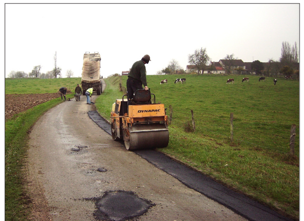
▷ Réfection de la chaussée, rue creuse (Hardroit)
