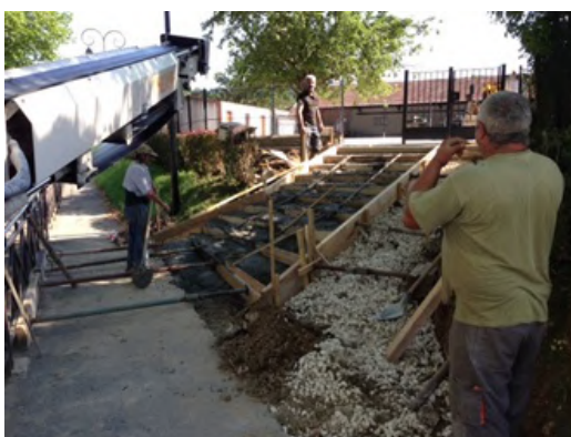
Les cantonniers lors de la réalisation des marches
