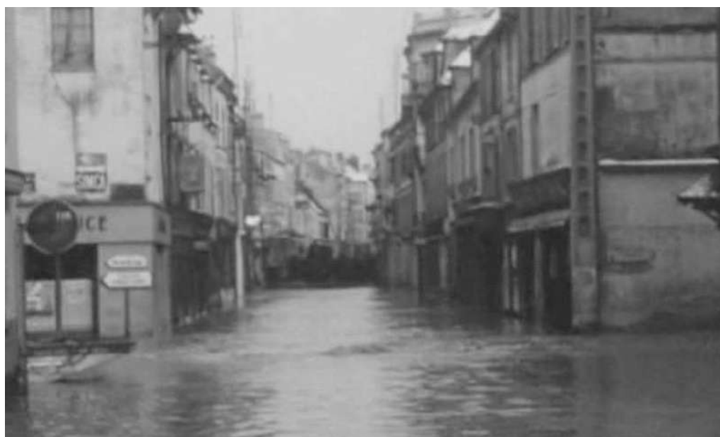
Crue de 1958 dans Coulommiers
